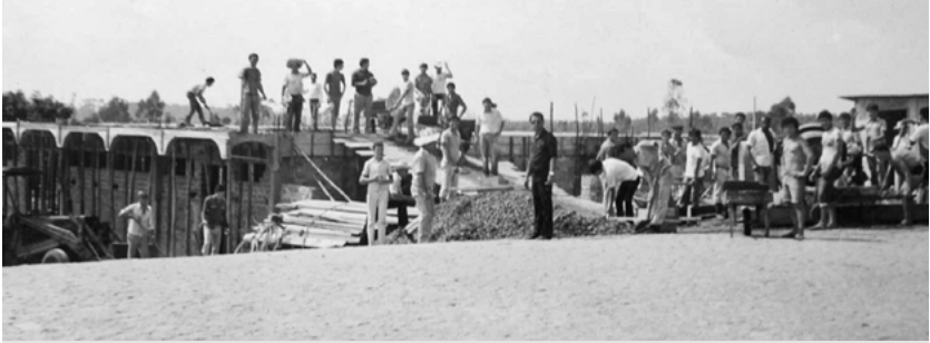
Construção do templo sede atual.
